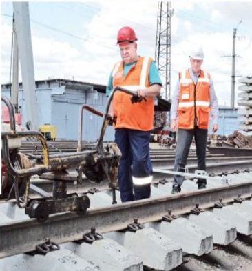
На монтаже рельсовой решетки Михаил Чубатов.
